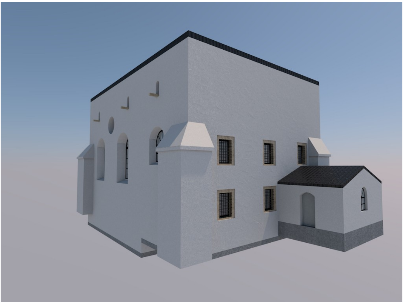
Abb. 27 Pinczow_Alpha_GER_S23 - Ansicht 2.jpg
