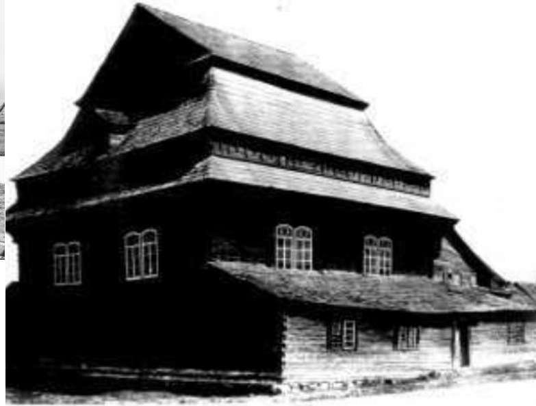
Widok od strony północnej
