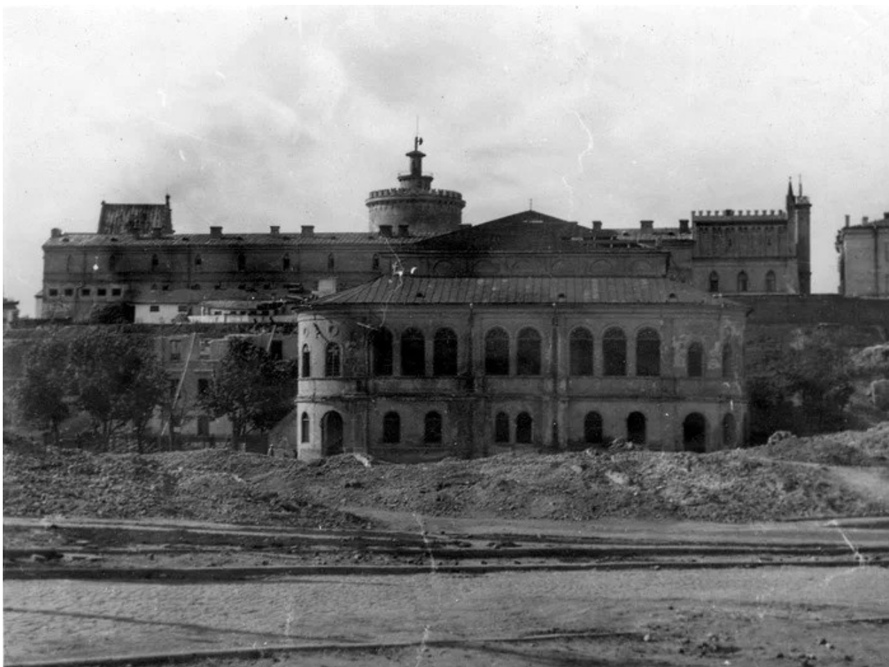
Abb. 3 Ansicht von Norden 1942
