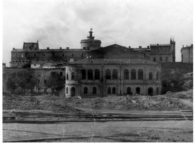
Abb. 3 Ansicht von Norden 1942
