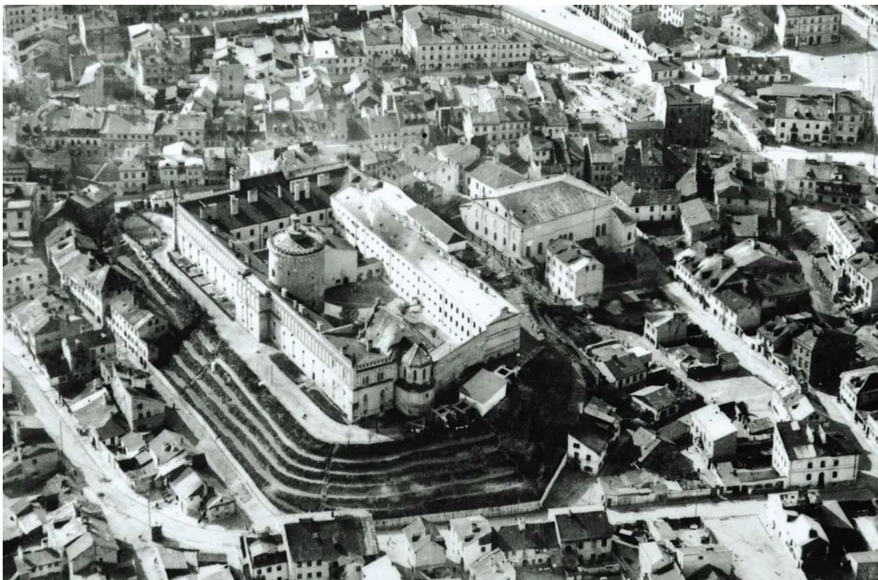
Abb. 11 Süd-Ost Ansicht der Synagoge
