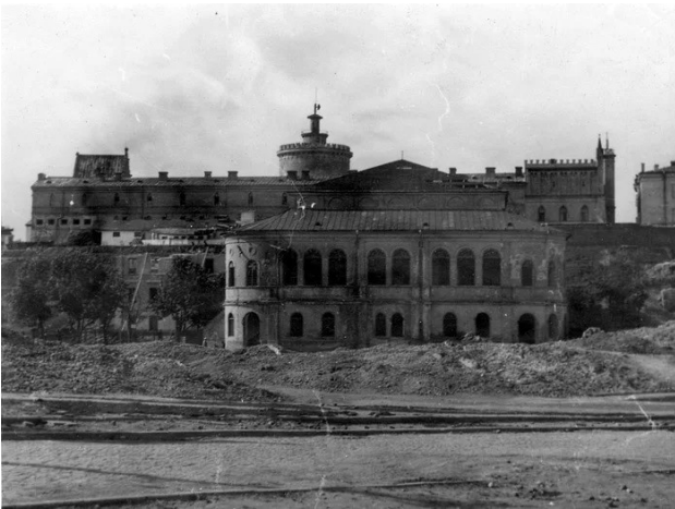
Abb. 3 Ansicht von Norden 1942
