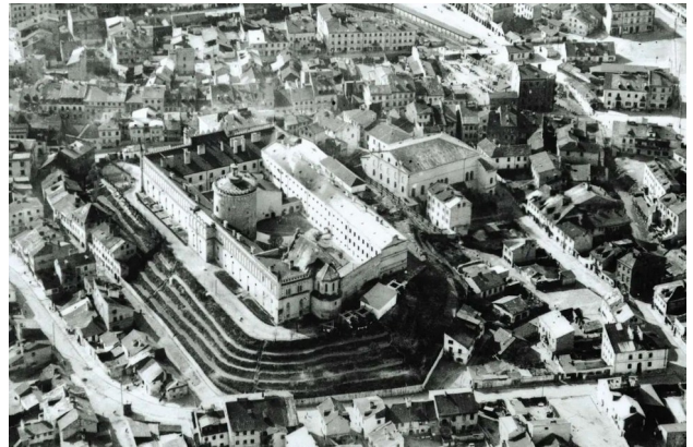
Abb. 11 Süd-Ost Ansicht der Synagoge
