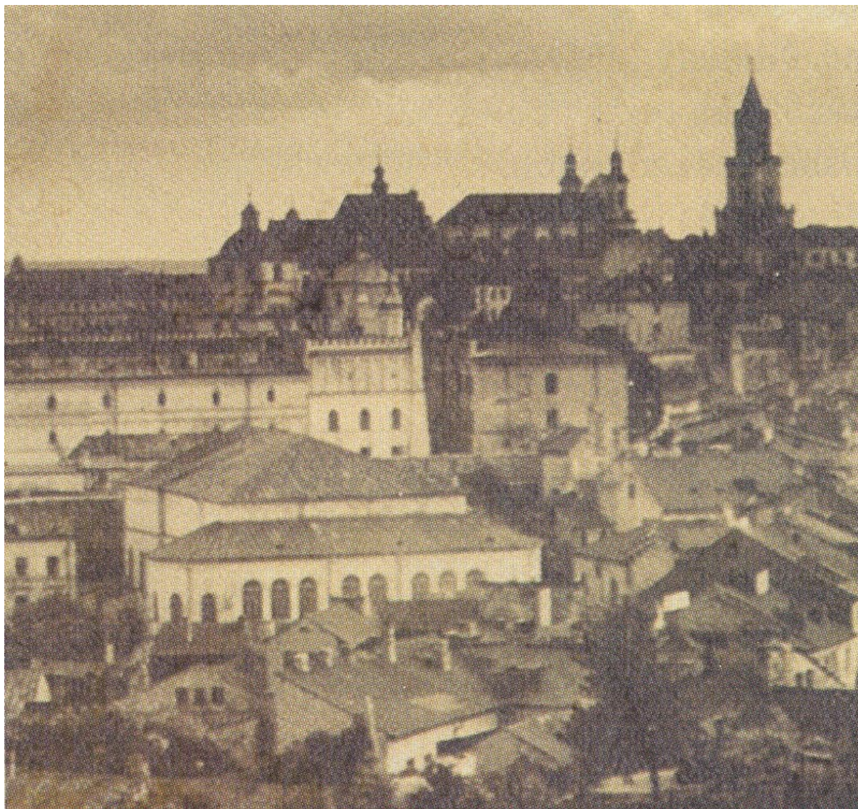
Abb. 18 Nord Ansicht und Dach
