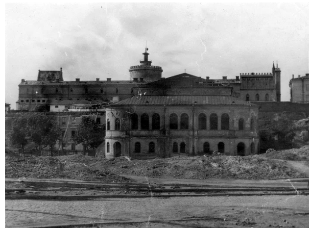
Abb. 3 Ansicht von Norden 1942
