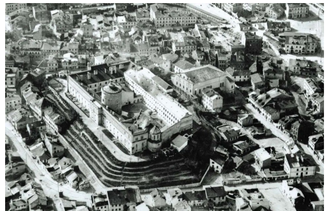
Abb. 11 Süd-Ost Ansicht der Synagoge
