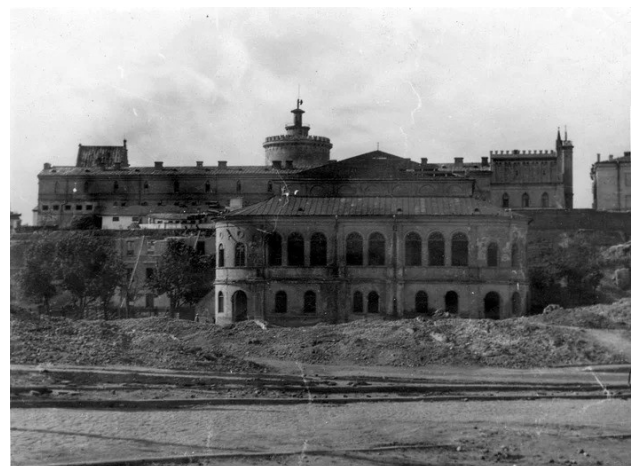
Abb. 3 Ansicht von Norden 1942
