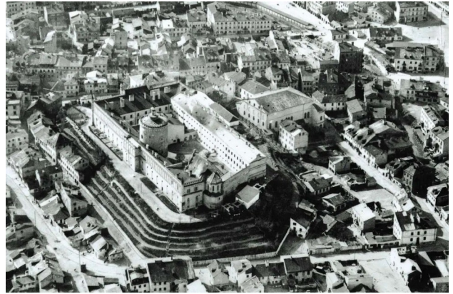
Abb. 11 Süd-Ost Ansicht der Synagoge
