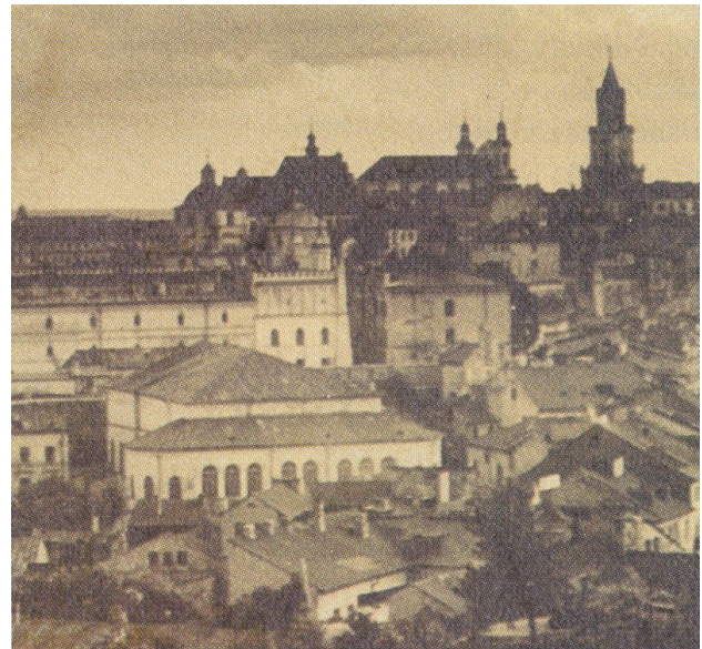
Abb. 18 Nord Ansicht und Dach
