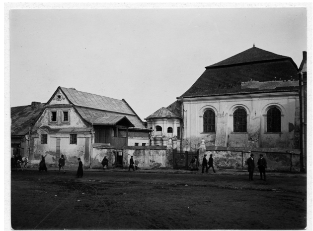
Abb. 27 Ansicht aus Südost
