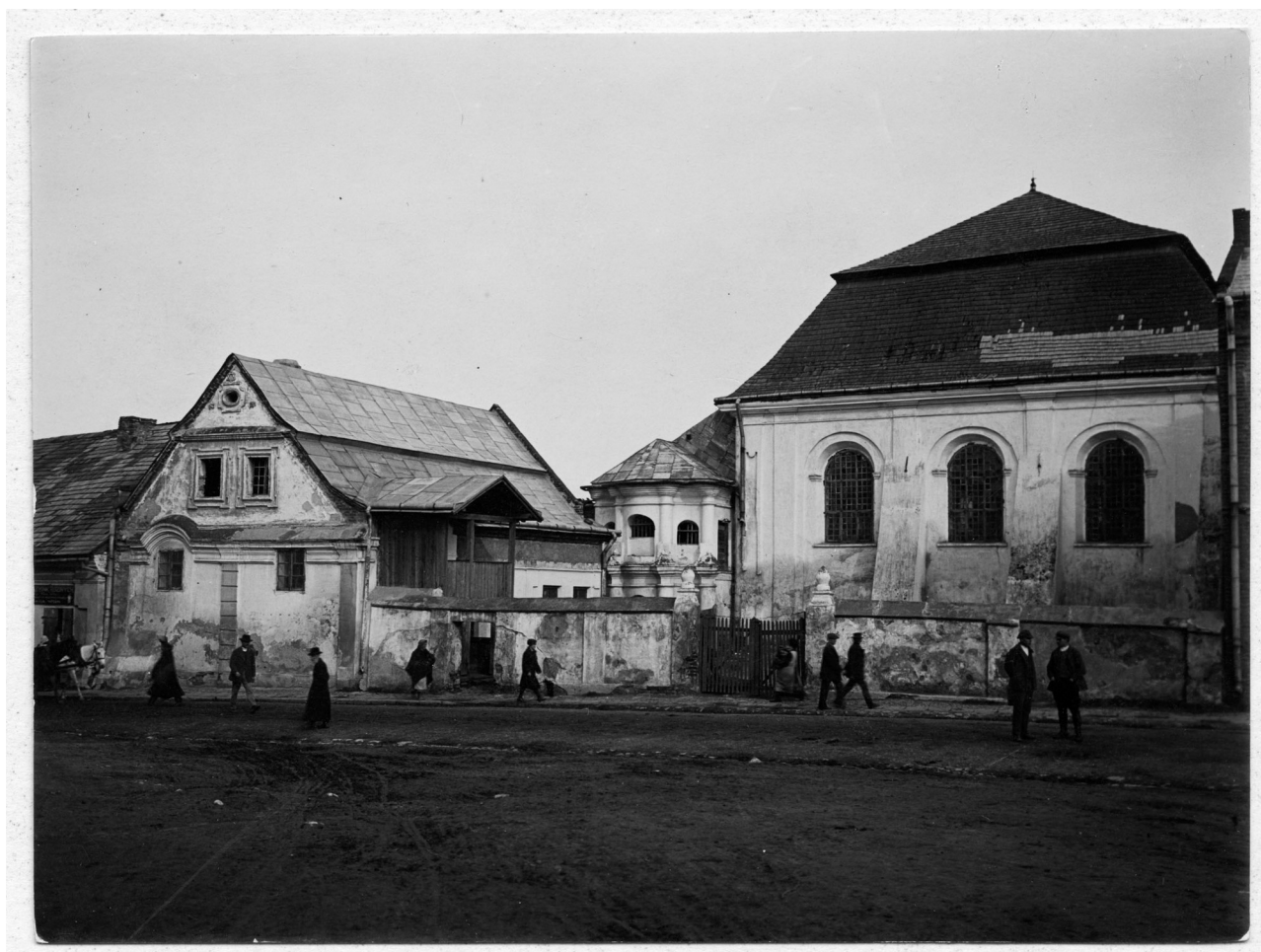
Abb. 27 Ansicht aus Südost
