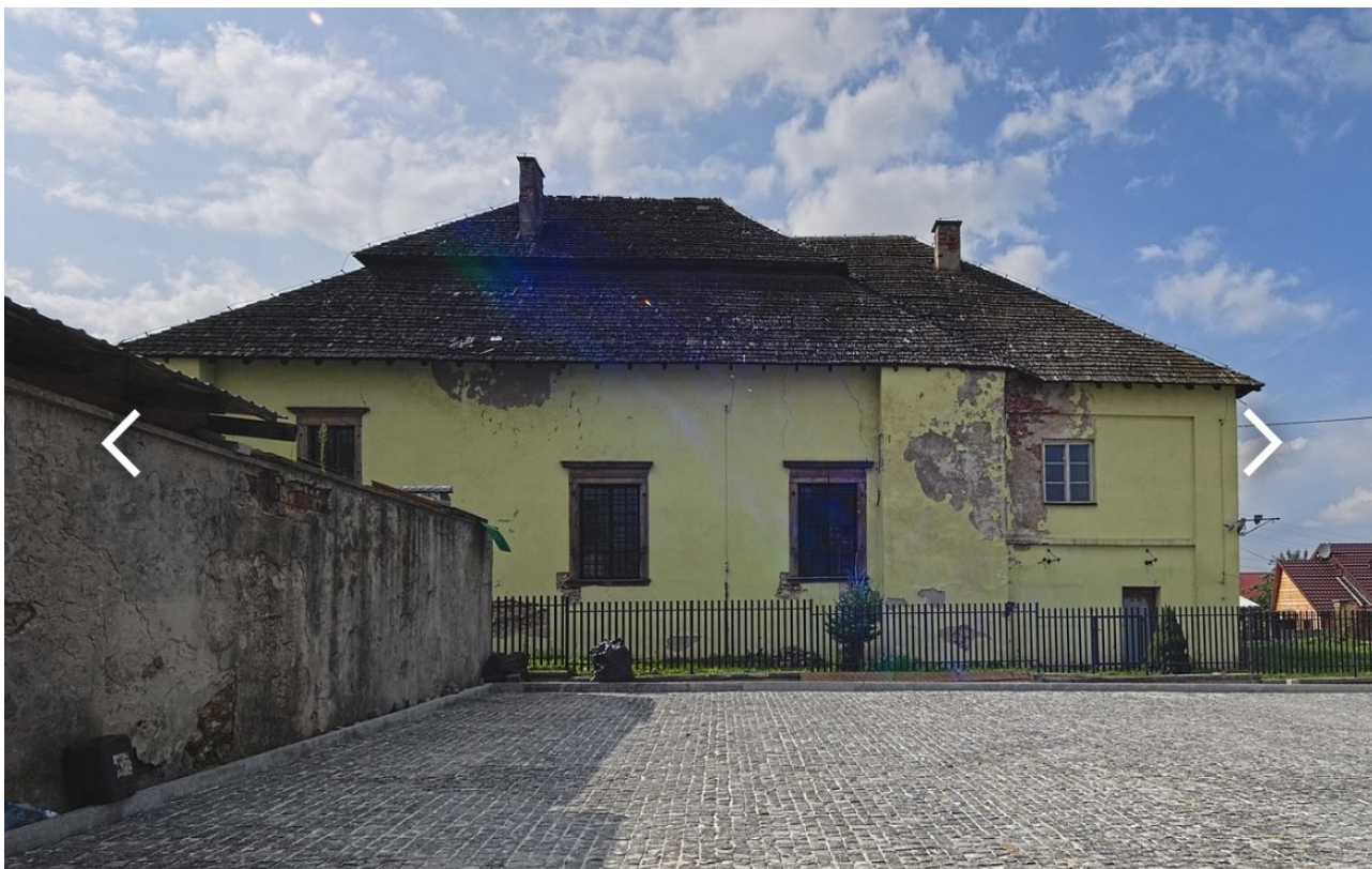
Abb. 14 Ansicht von Osten vom 14. August 2022
