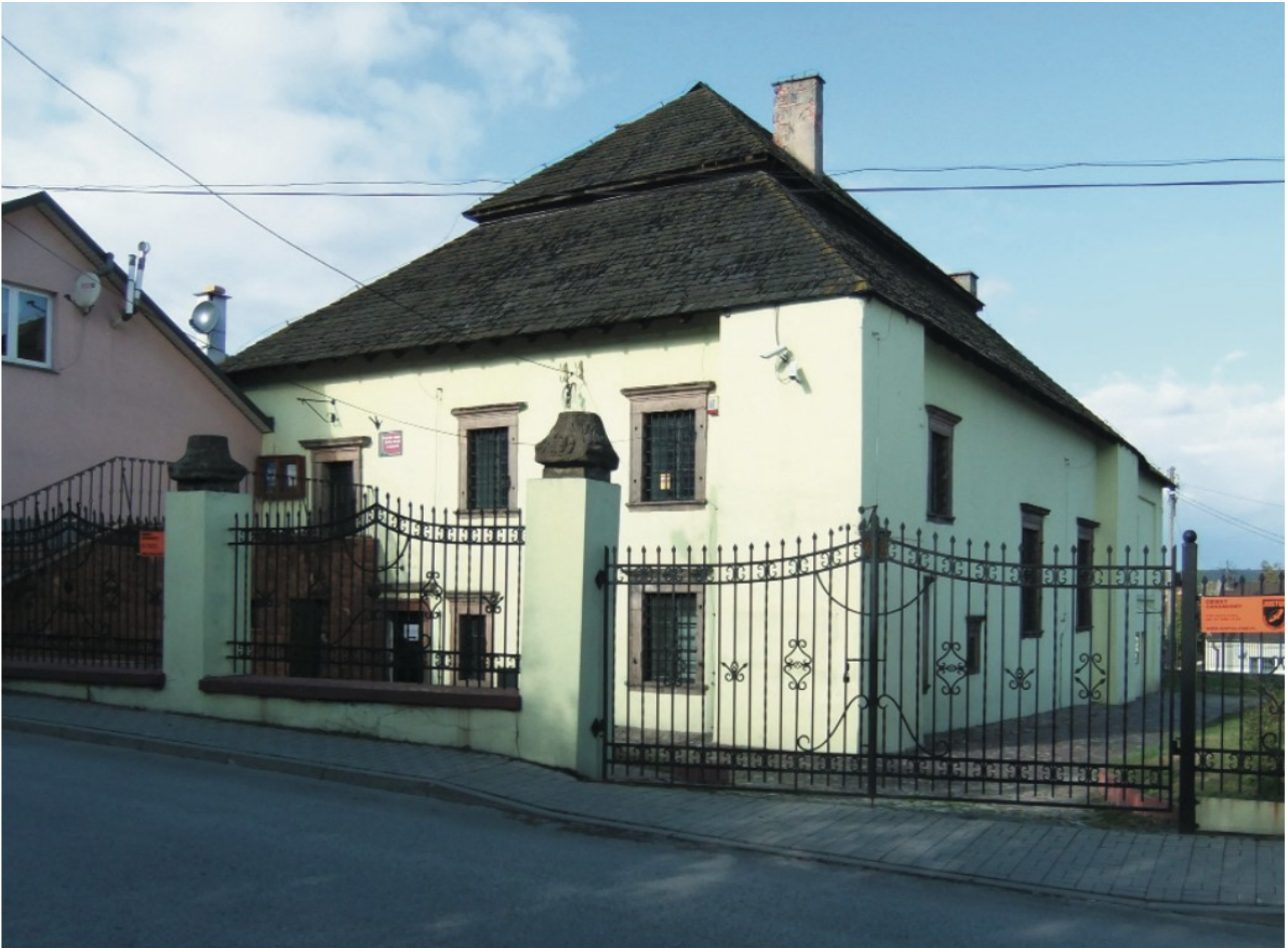
Abb. 16 Ansicht von Südosten 2015
