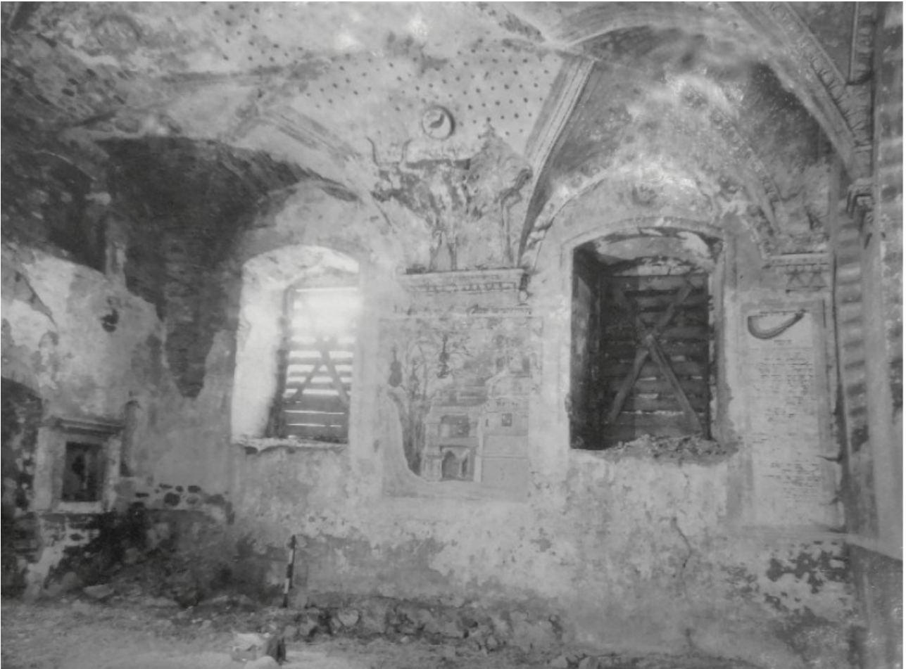
Abb. 17 Innenraum der Haupthalle 1958
