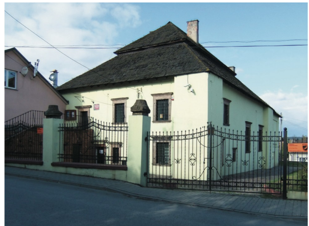
Abb. 16 Ansicht von Südosten 2015
