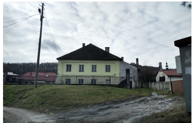
Abb. 10 Ansicht von Norden
