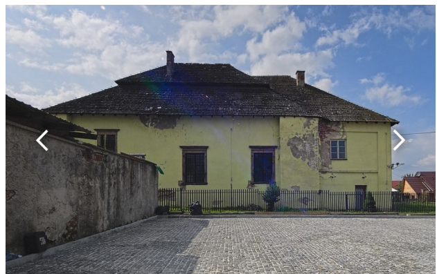
Abb. 14 Ansicht von Osten vom 14. August 2022
