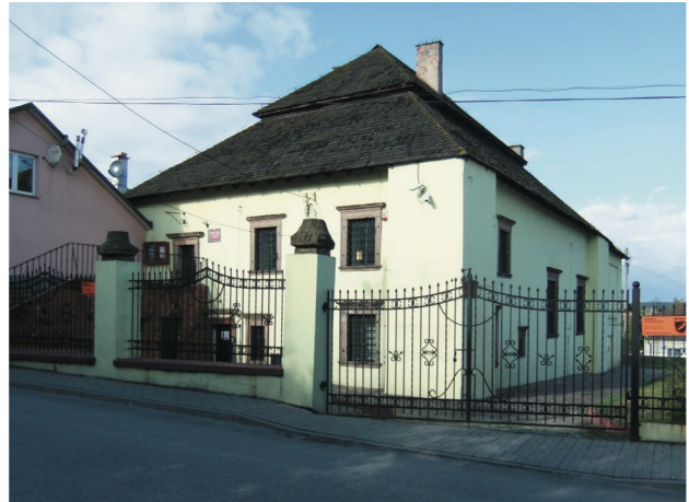
Abb. 16 Ansicht von Südosten 2015
