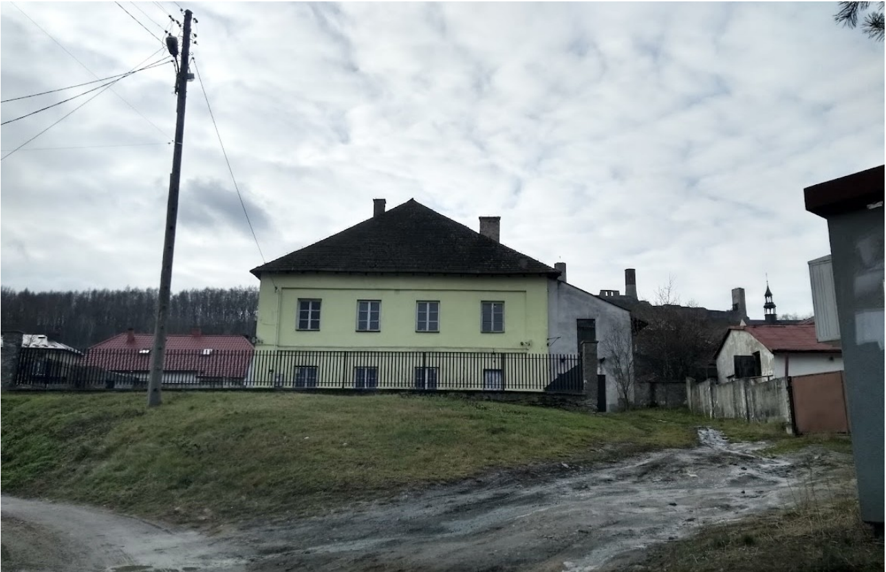
Abb. 10 Ansicht von Norden
