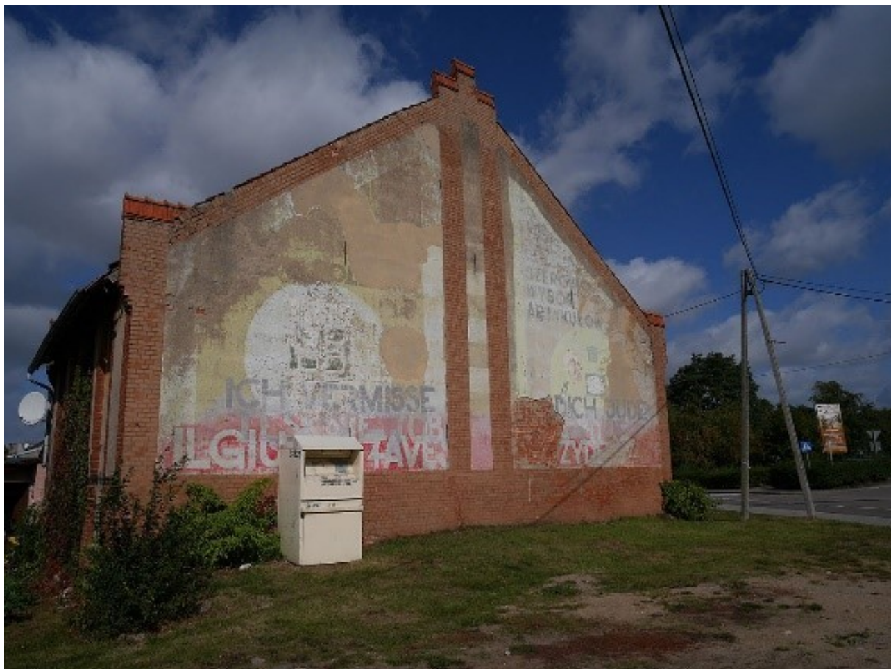
Abb. 8 Foto ehem. Synagoge in Dabrówno
