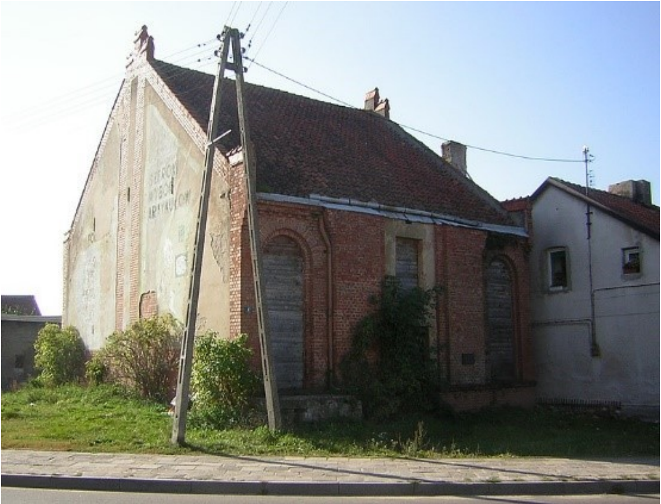
Abb. 7 Foto ehem. Synagoge in Dabrowno
