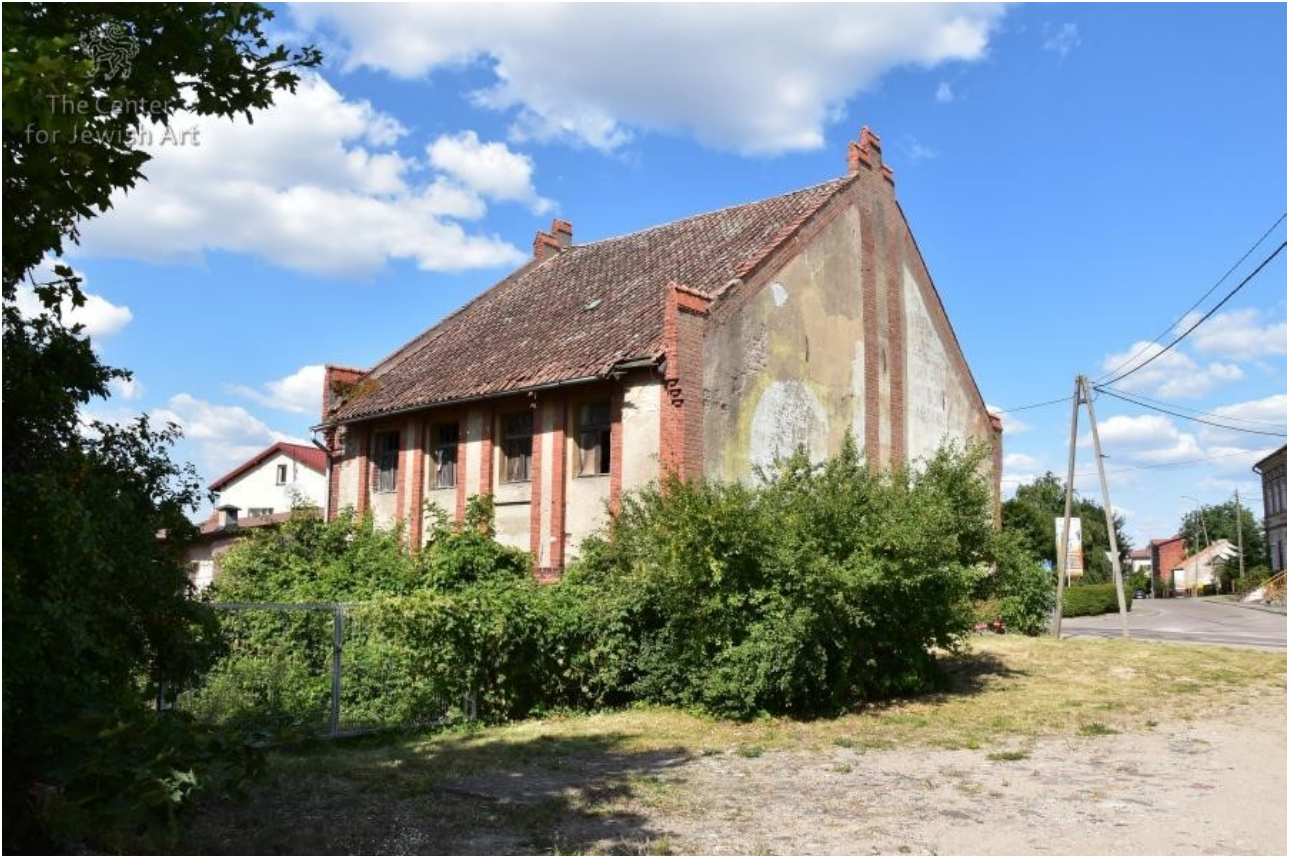
Abb. 9 Foto ehem. Synagoge in Dabrowno
