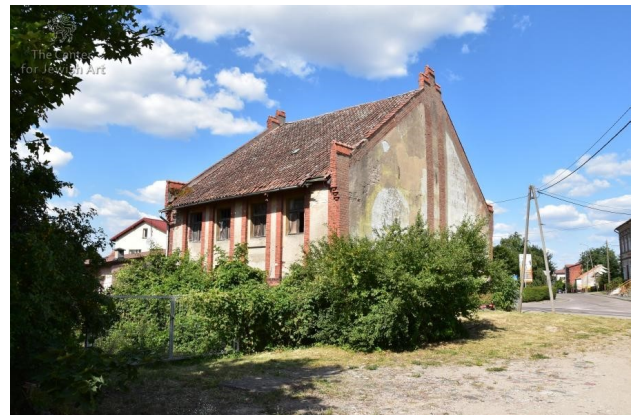
Abb. 9 Foto ehem. Synagoge in Dabrowno
