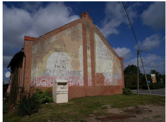
Abb. 8 Foto ehem. Synagoge in Dabrowno
