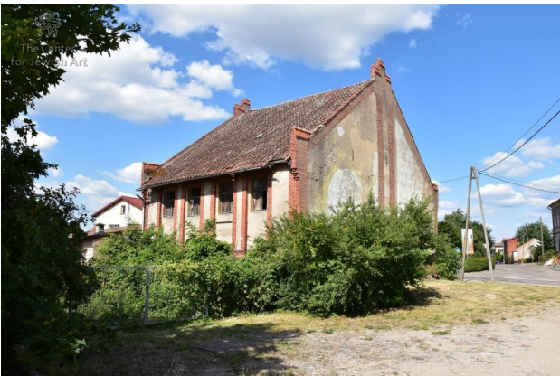
Abb. 9 Foto ehem. Synagoge in Dabrówno
