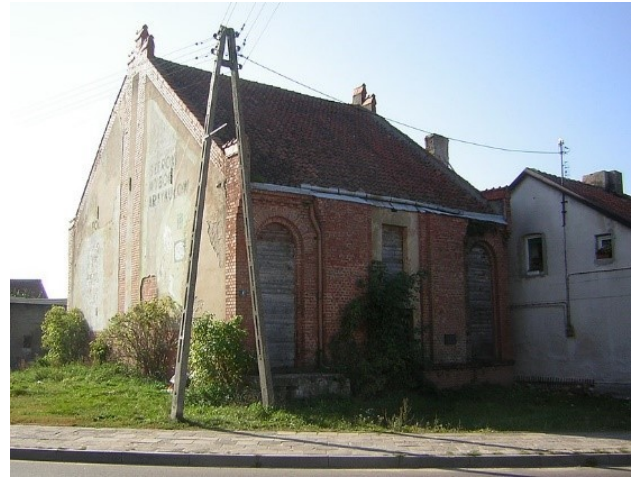
Abb. 7 Foto ehem. Synagoge in Dabrówno
