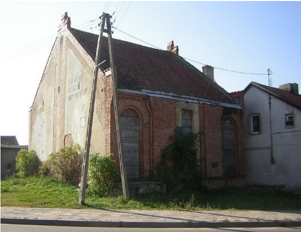
Abb. 7 Foto ehem. Synagoge in Dabrówno
