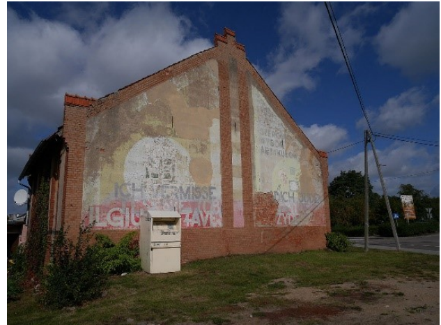
Abb. 8 Foto ehem. Synagoge in Dabrówno
