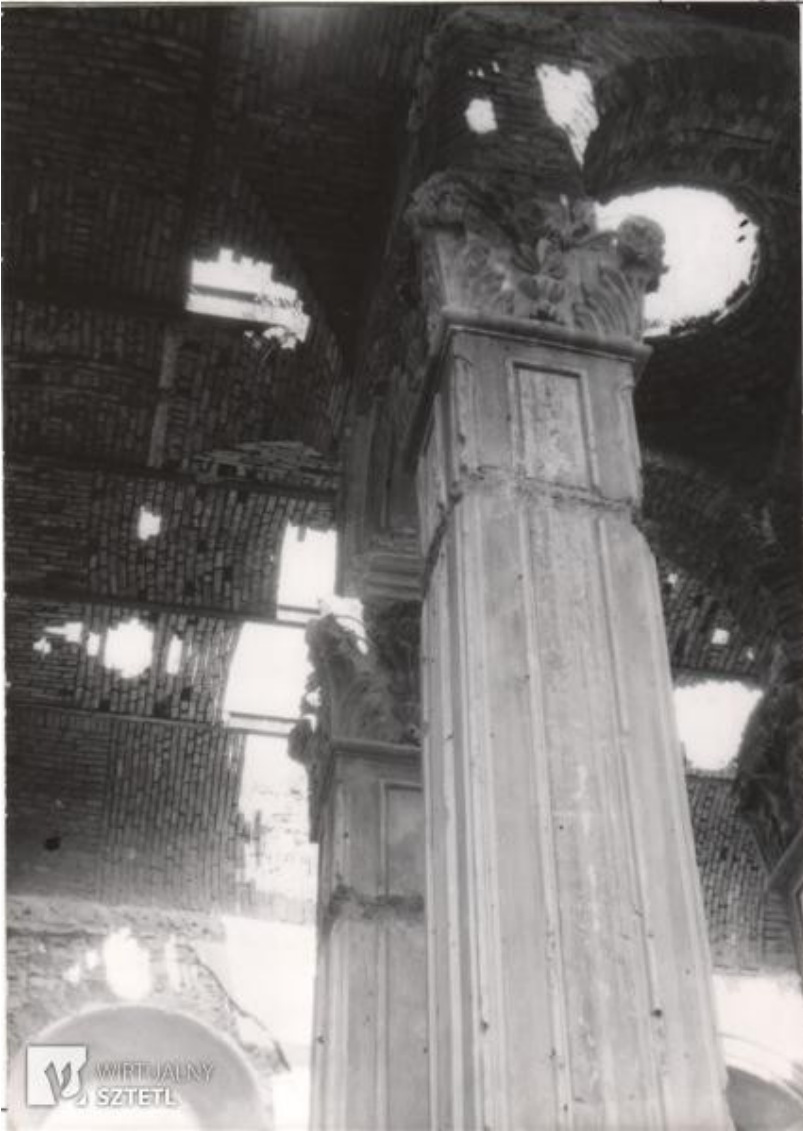
Abb. 28 Innenraum Pfeiler Decke
