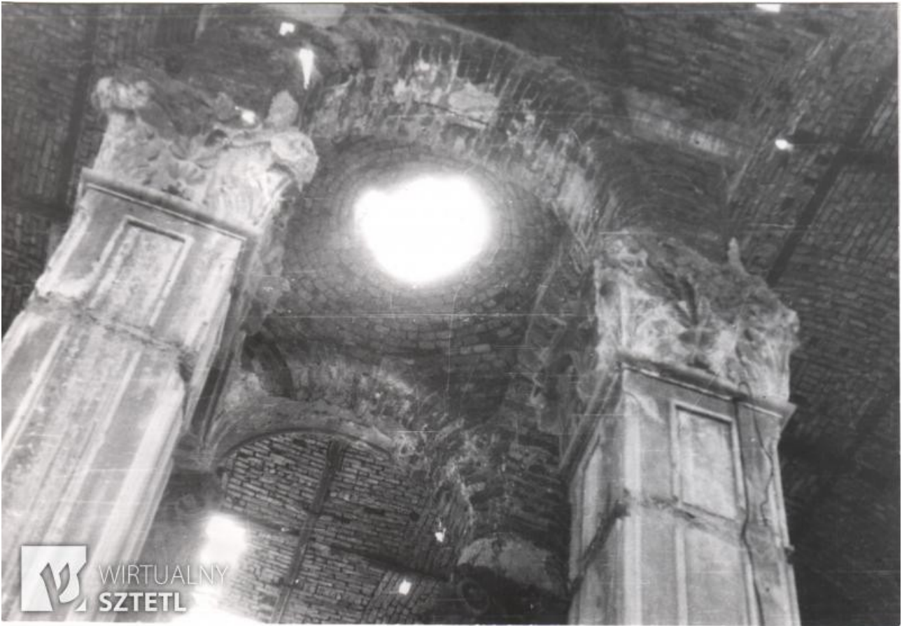
Abb. 26 Pfeiler mit Gewölbe und Kuppel
