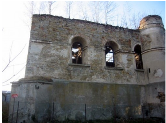
Abb. 38 Rymanow Ansicht Nord
