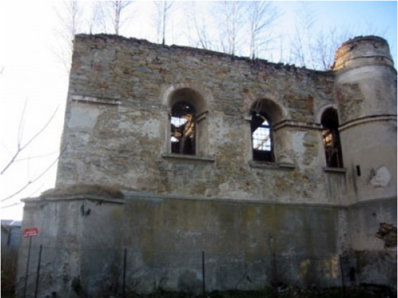
Abb. 38 Rymanow Ansicht Nord
