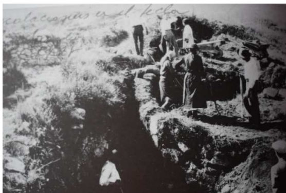
Fig.: 2. Pormenor de los trabajos dirigidos por Mergelina (Rodríguez Martínez, 2017: 42).
