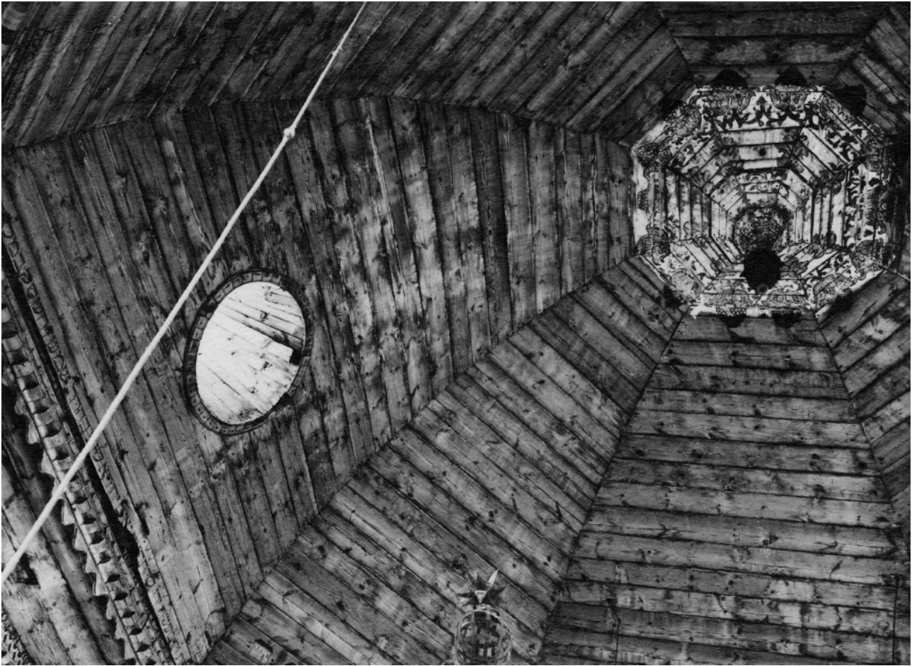
Fig. 26 Widok na sklepienie i światlik
