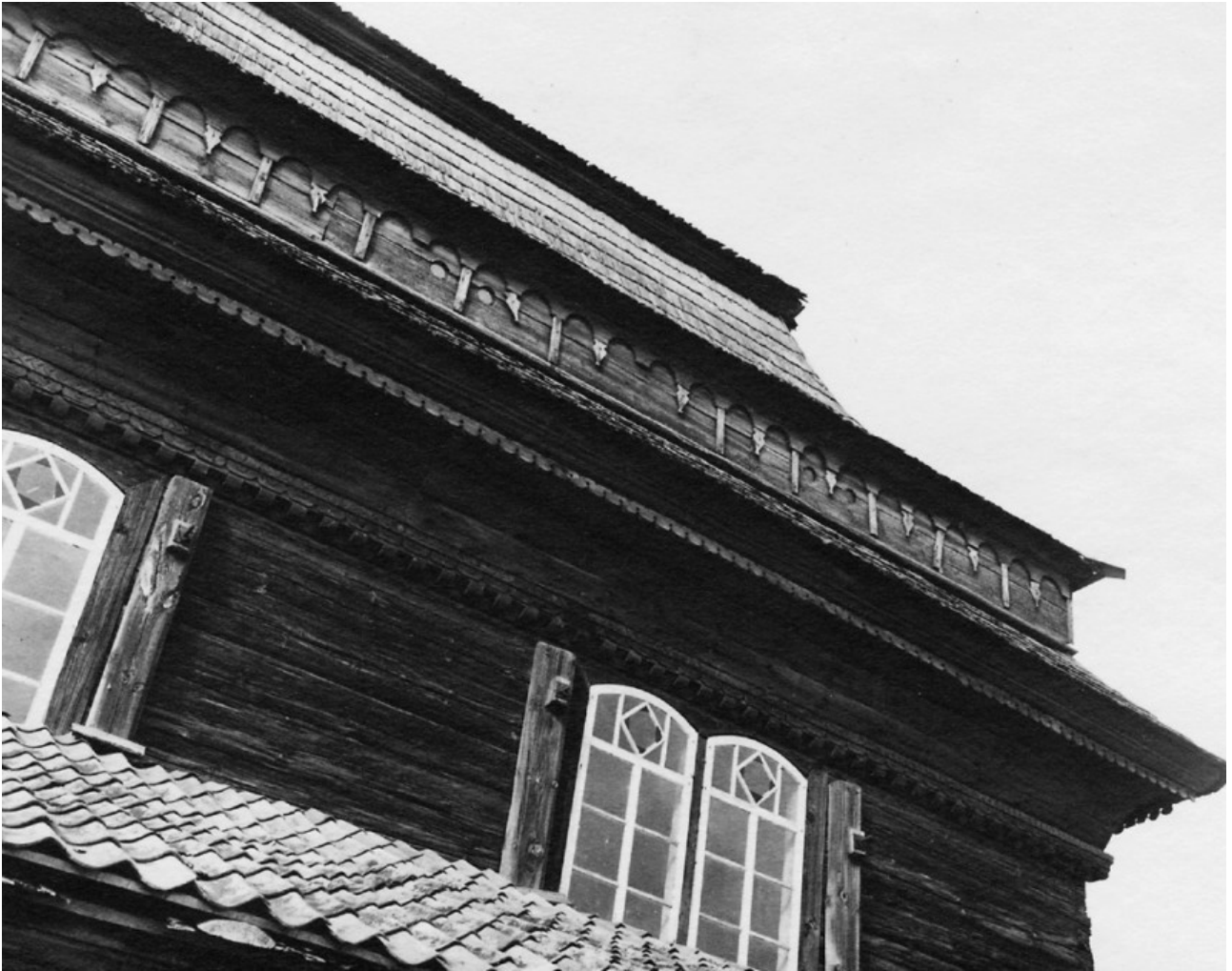
Fig. 22 Detal na południowej elewacji
